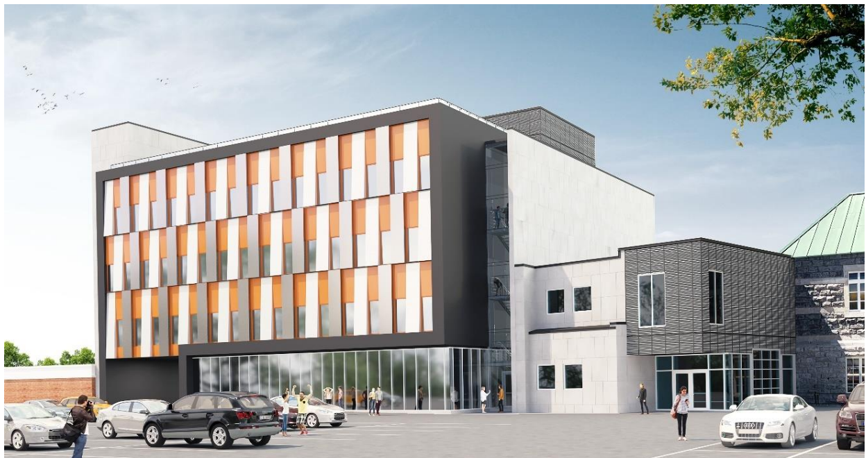
Projet 2024-2025 — Réalisation de la phase II de l'Institut technologique Desjardins
